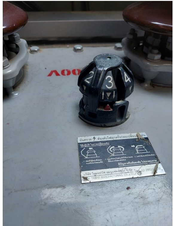
ตำแหน่งแท็บปรับแรงดันไฟฟ้า
